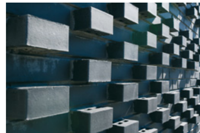
Das Mauerwerk im Detail: Die vorgeschobenen Steine schaffen eine unvergleichliche Textur des Korpus. ▶
