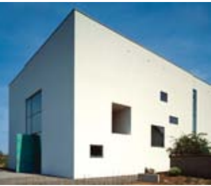
▲ Erst in der Annäherung sind die einzelnen Steine des Pfarrzentrums St. Franziskus (Regensburg) zu erkennen.
