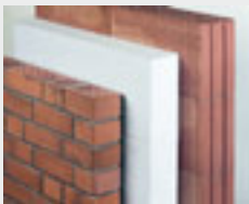
11,5 cm Vormauerziegel 10 cm PU-Dämmschicht 15 cm Porotonziegel
