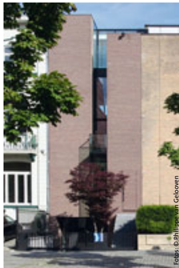
▲ Das Stadthaus von seiner Eingangsseite
