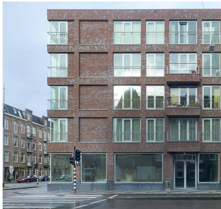
▲ Neuinterpretation: Die Mauerwerkselemente der Nachbargebäude spiegeln sich in der neuen Fassade wider.
