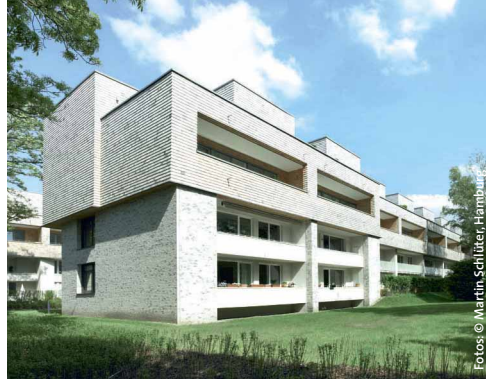
◀ Wandlung: Die Siedlung vor und nach der Sanierungsmaßnahme.
