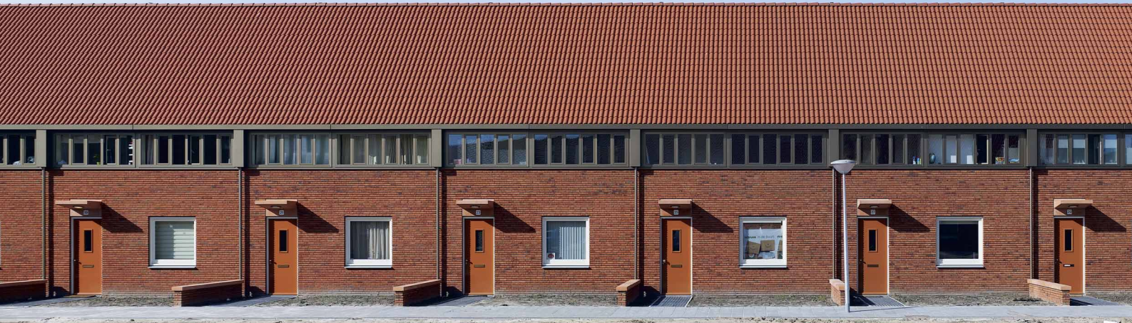
▲ Die lange Häuserreihe – bestehend aus Standard-Reihenhäusern – flankiert den Hauptplatz.
