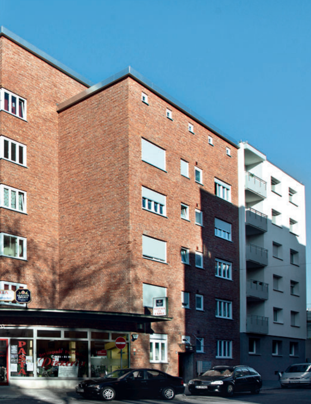
▲ Ansicht Ecke Bahnhofstraße und Bürgermeister-Kutterer-Straße: Die klassische Bauhaus-Stilistik der denkmalgeschützten Backsteingebäude blieb bei der Sanierung erhalten.
