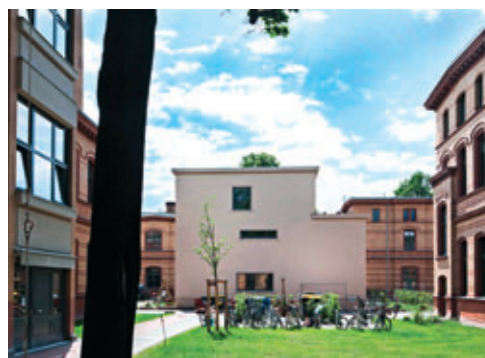
▲ Ergänzung: Neubau inmitten des historischen Bestands.
