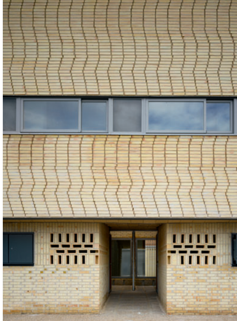
Irritierend: Der ungewöhnliche Mauerwerksverband erinnert an durchgerüttelte Backsteinstapel. ▶
